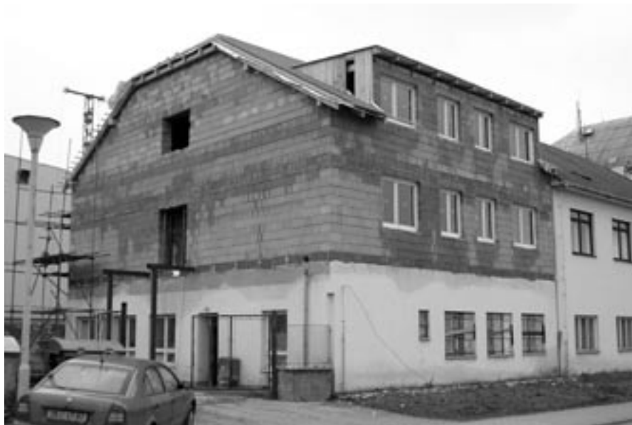
Pohled na hrubou stavbu čtyř bytových jednotek, zatlučená okna v přízemí se změní na další byty
