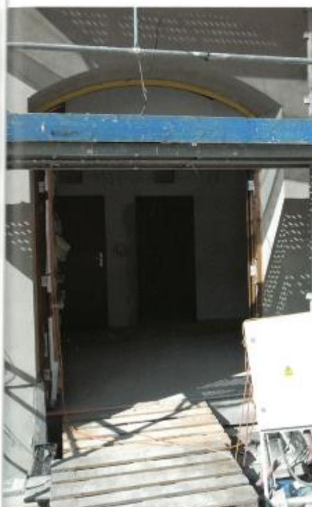
■ KLENUTÝ VSTUP Pamatujete si ještě původní?
