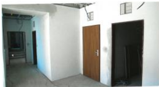
■ UŽ TO PŘIPOMÍNÁ VÍC ŠKOLKU, NEŽ STAVENIŠTĚ. Omítky schnou, ale pomalu.
