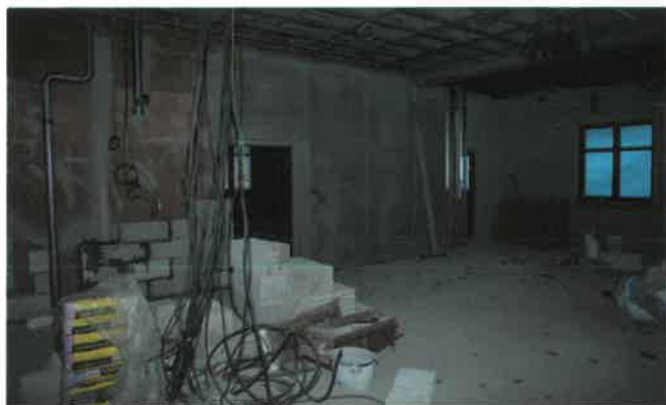
█ ŘEMESLNÍCI SE NECHTĚLI FOTIT. Ale práce pokračují na všech frontách – klimatizace, elektroinstalace, omítky...
