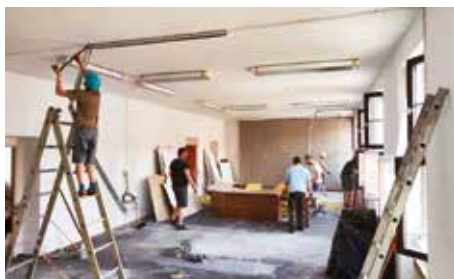
Stavební úpravy v nových prostorech. | Foto: Archiv ZŠ Lípa
