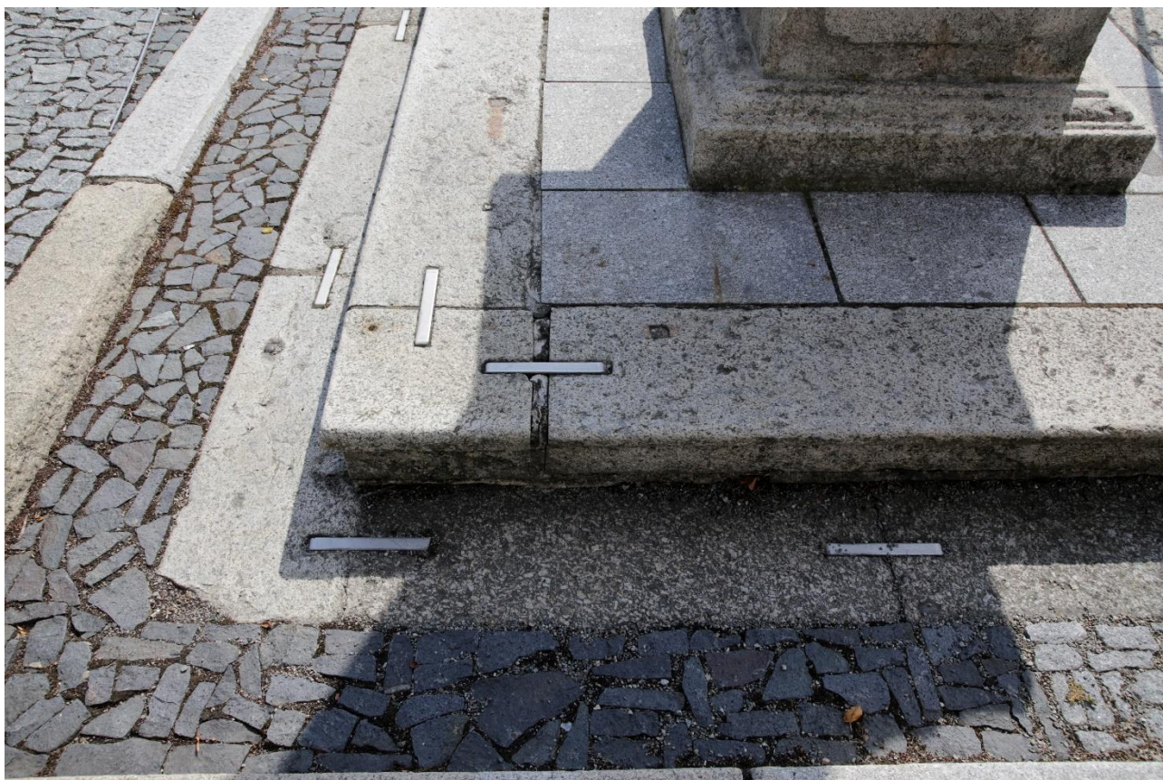
Obrázek 36 schodiště, novodobé kramle a nová zádlažba podesty
