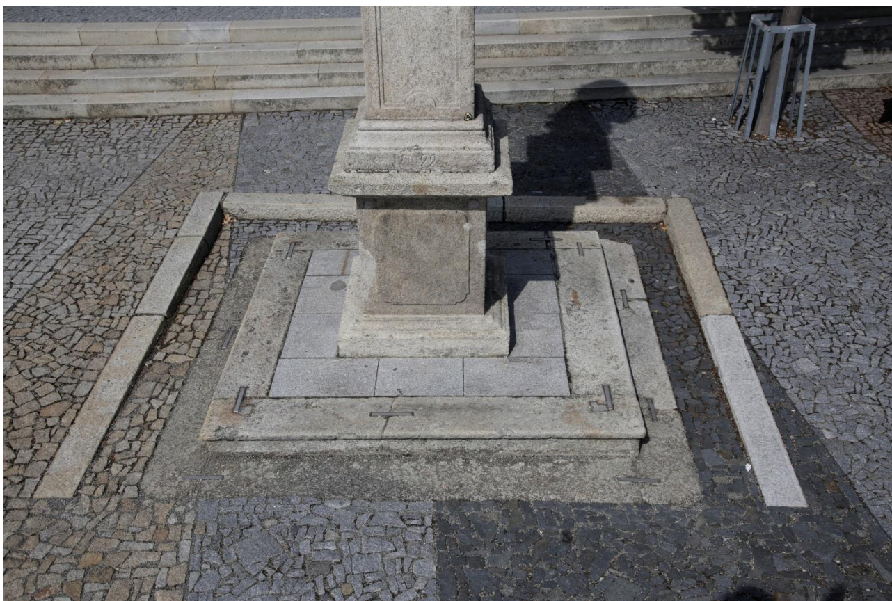
Obrázek 31 žulový sokl sochy se schodištěm, zapuštěný v současném terénu náměstí
