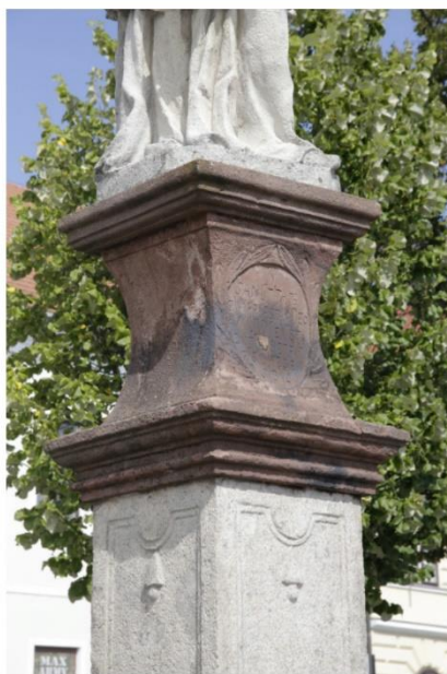
Obr. 1: Sokl pod sochu sv. Jana Nepomuckého s šedo-černou vrstvou povrchových úprav. Stav před restaurováním, foto: Z. Kovářík, 2024.
