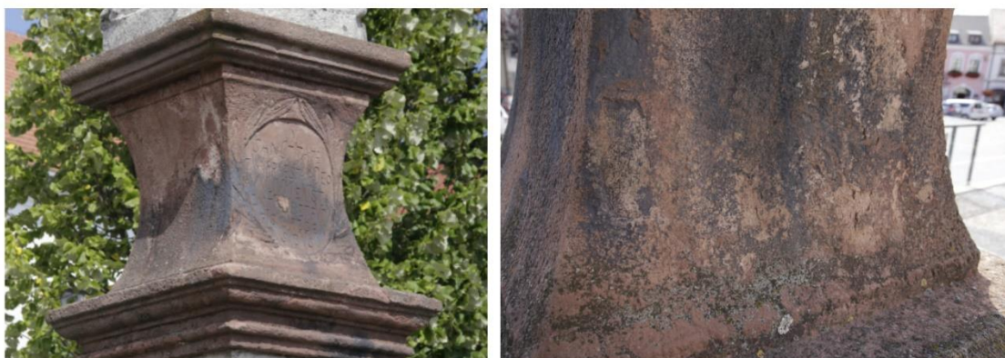
Obr. 2a, b: Povrchová úprava zvýšeného soklu, vpravo detail povrchové šedo-černé vrstvy nanesené na načervaném pískovce. Foto: Z. Kovářík, 2024.
