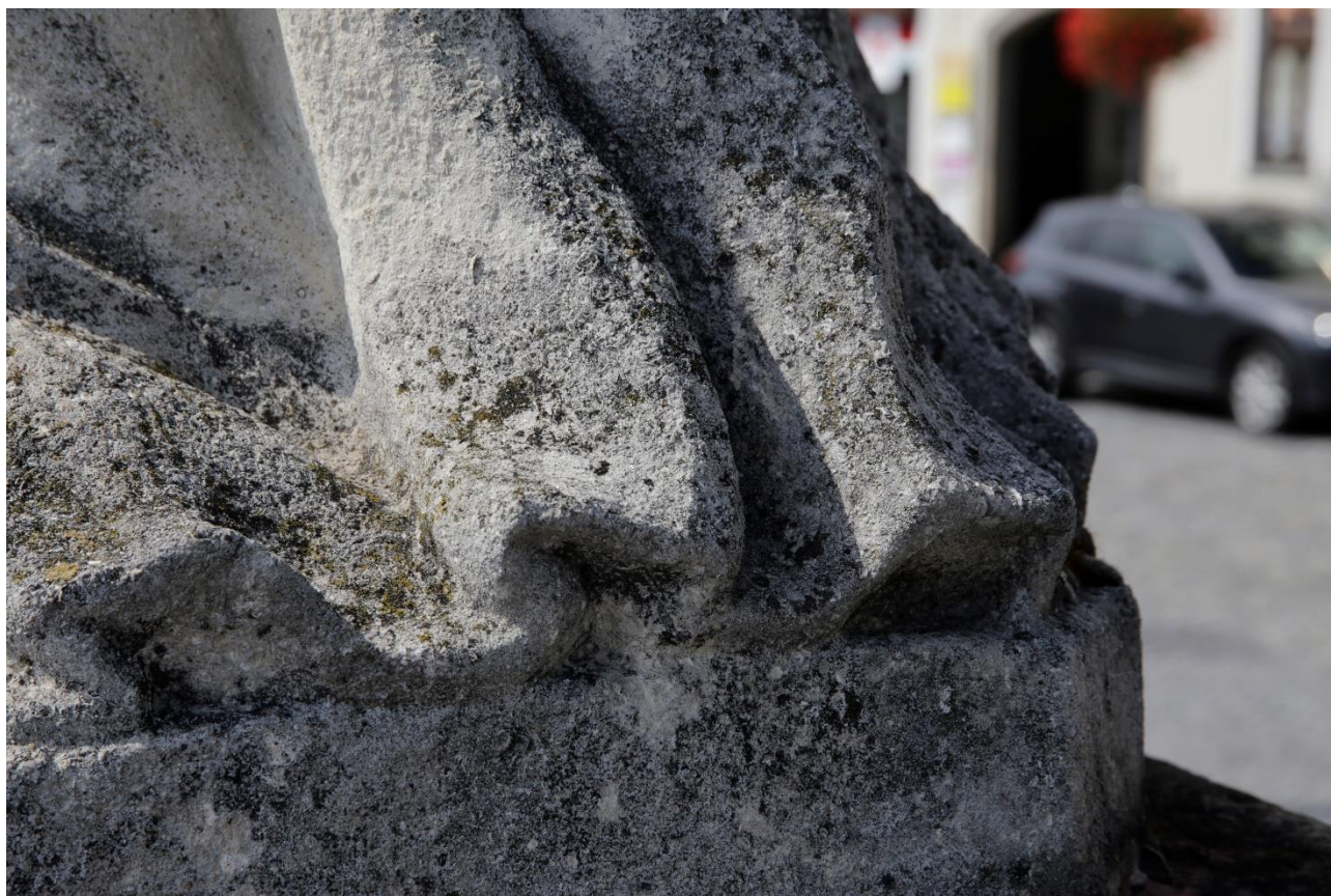
Obrázek 26 socha sv. Jana, detail: biologické napadení povrchu
