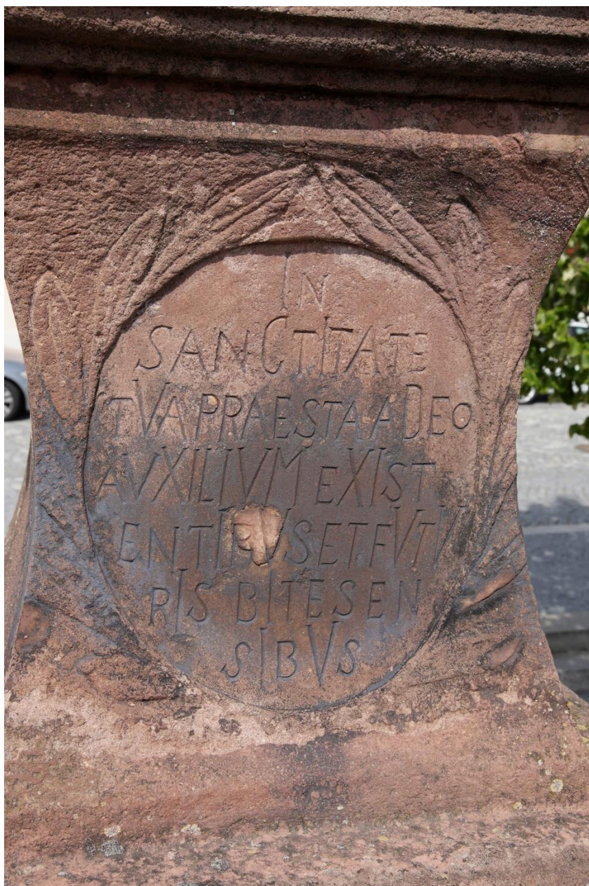
Obrázek 27 pískovcový sokl, nápisová kartuš, celoplošný doplňěk
