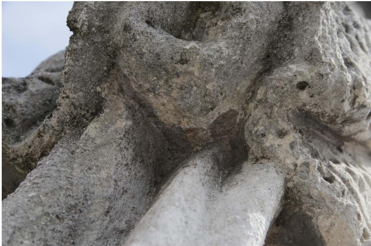
Obrázek 23 socha sv. Jana, detail: krusty a degradace povrchu
