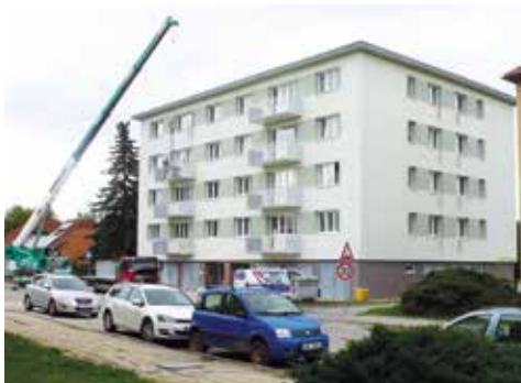
Zavěšování balkonů na nově zrekonstruovaný dům č. 377. Foto: Alois Koukola
