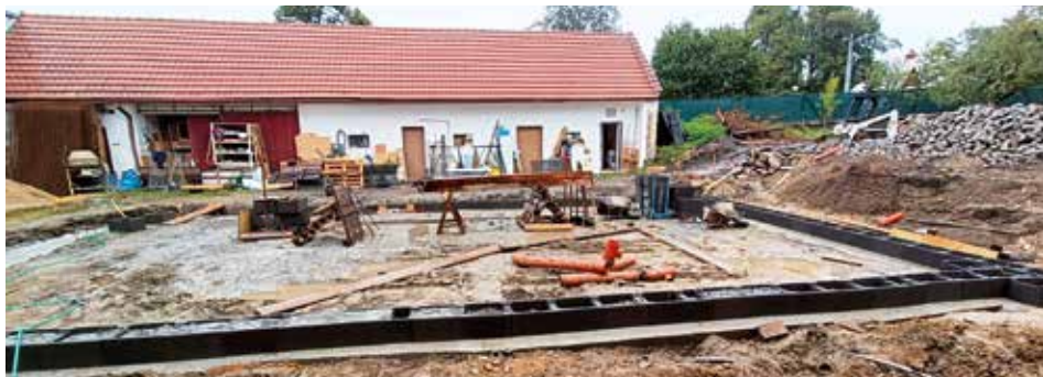
Základy budovy farního sálu na farním dvoře. | Foto: Archiv farnosti
