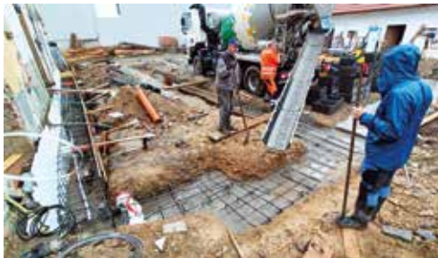
Výstavba farního sálu začala v září betonováním základů.
