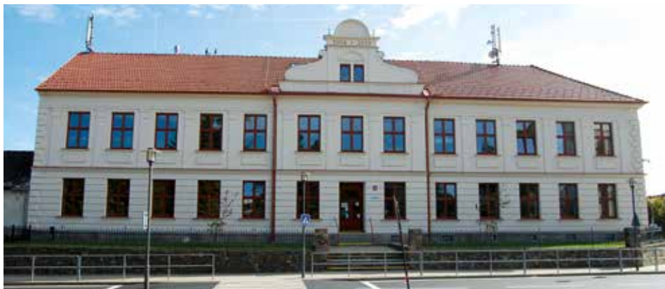
Školní budova čp. 115 po historizující rekonstrukci z roku 2019, v současnosti. | Foto: autor
