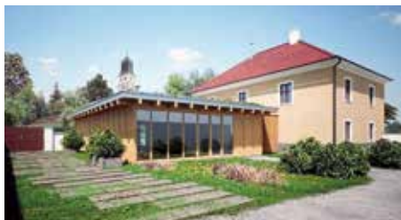
Přístavba farního sálu. | Foto: Archiv farnosti
