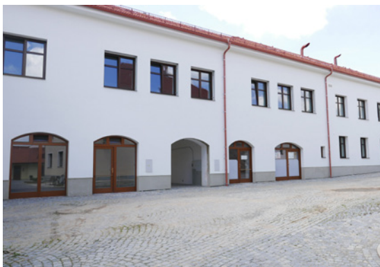
Rekonstruovaná Mateřská škola. | Foto: Silvie Kotačková
