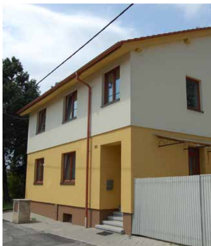
Současný stav domu č. 155. | Foto: Jan Zduba
