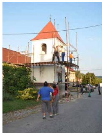
Oprava zvoníčky. | Foto: Archiv obce
