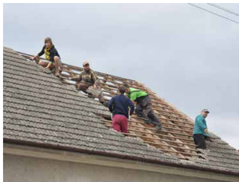
Oprava kulturního domu. | Foto: Archiv obce
