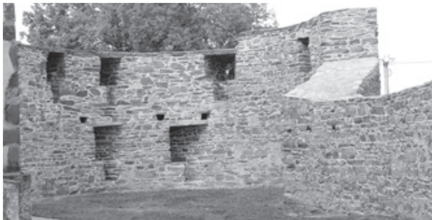
Vnitřní pohled na opravené hradby.
