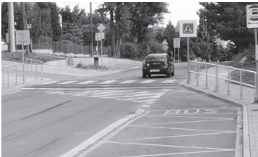
Zvýšený přechod v provozu.
