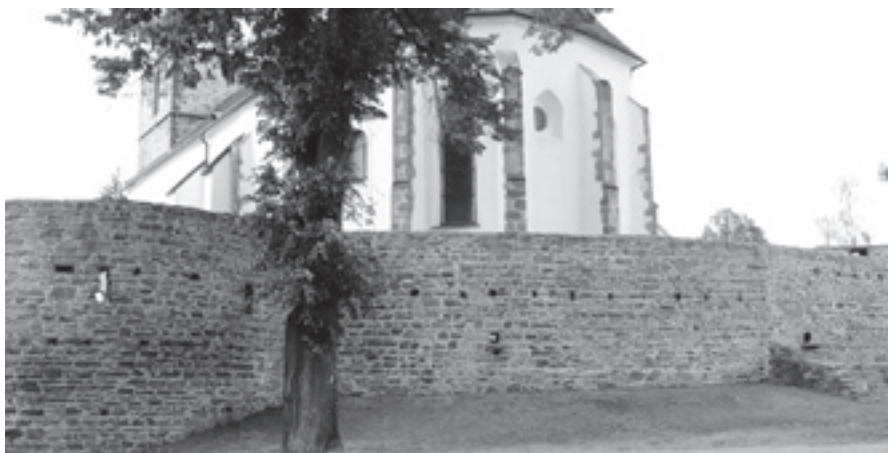
Vnější pohled na opravené hradby.
