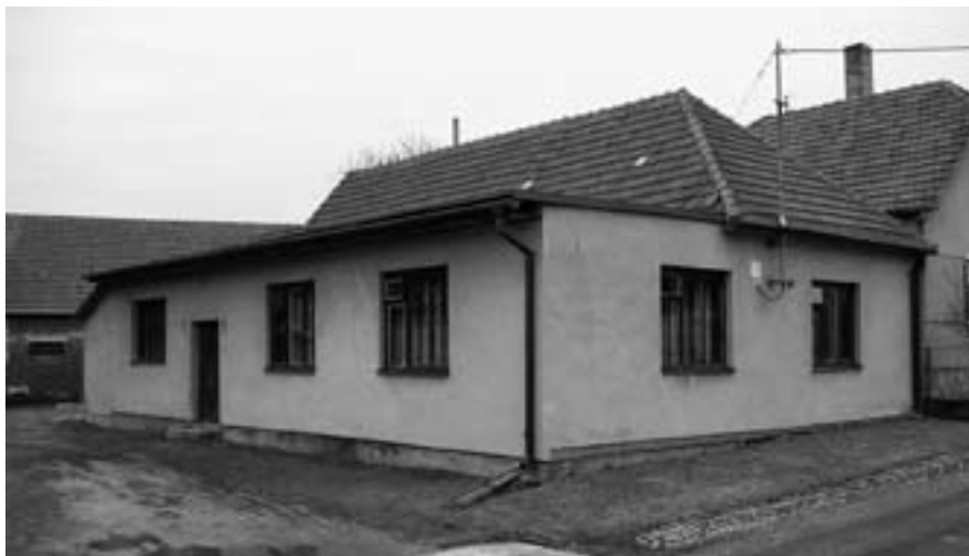
Nemovitost č.p. 15 v Jáchymově.
