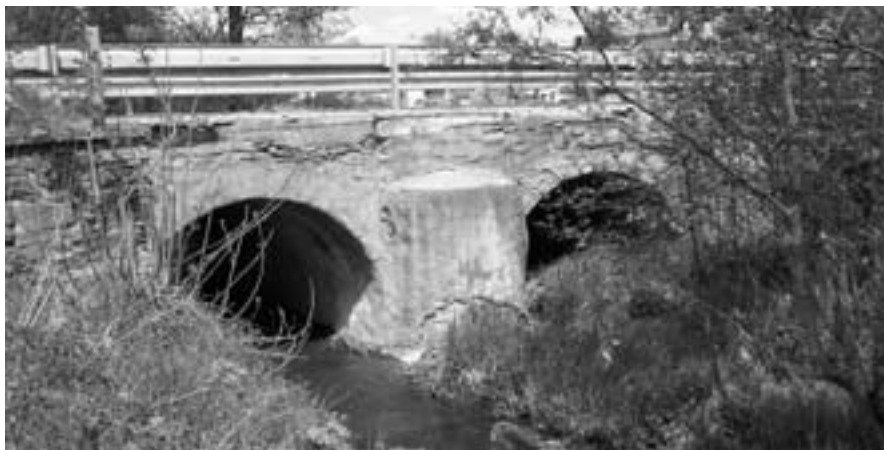
Současný stav mostu - 11. 5. 2006
