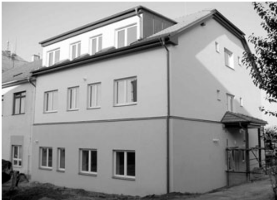
Dokončený bytový dům.
