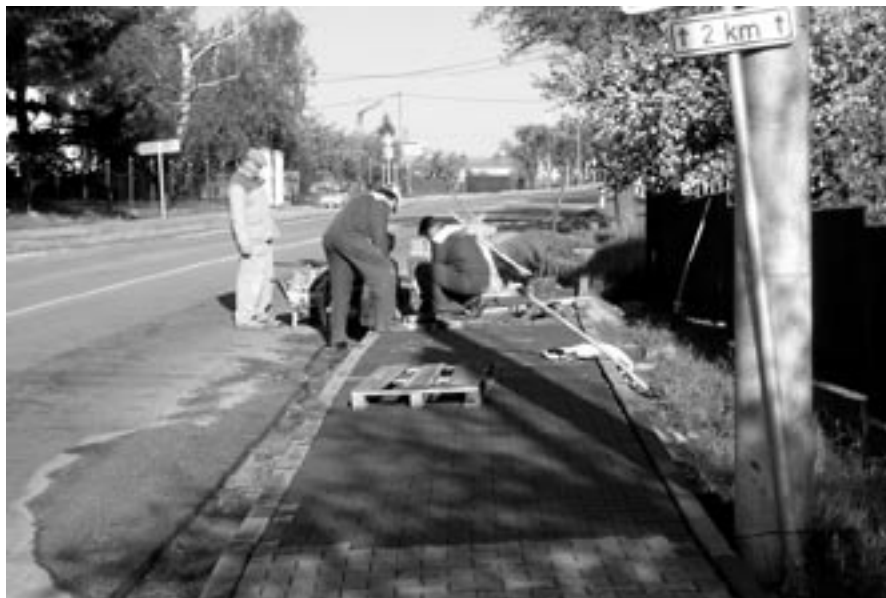
Pracovníci TS dokončují položení posledních metrů zámkové dlažby.
