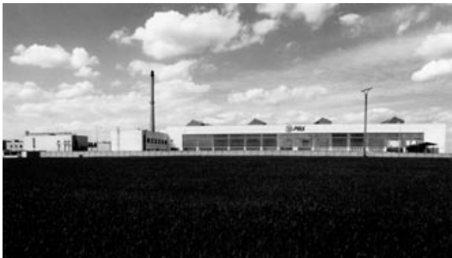
Pohled na výrobní halu divize letecké techniky.
