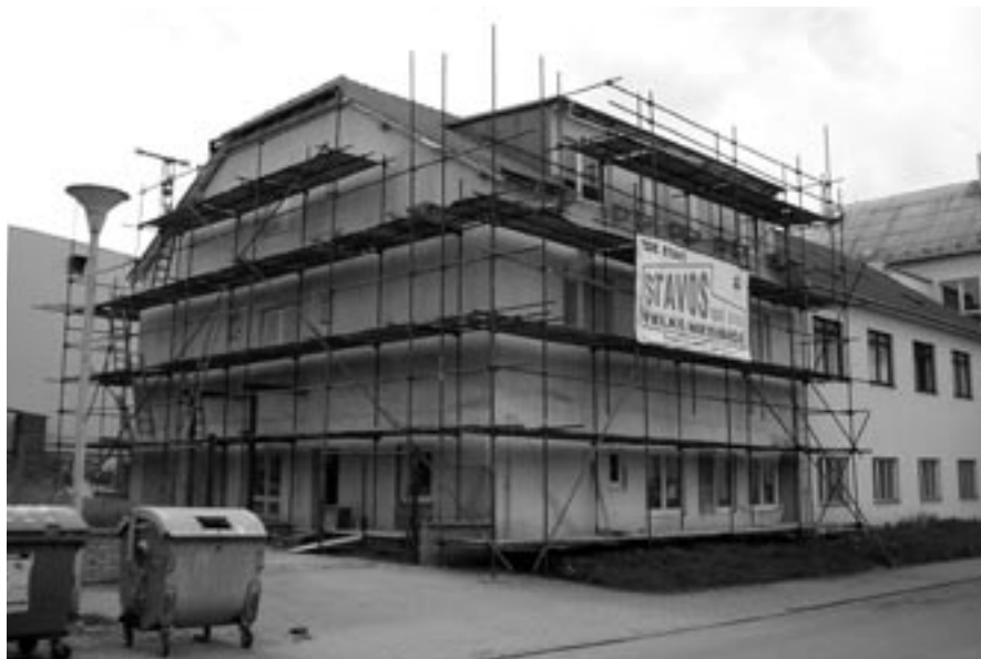
Pohled na dokončenou hrubou stavbu bytového domu.
