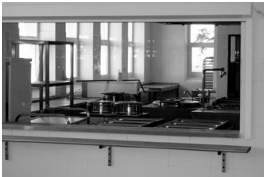
Pohled do městské kuchyně - ul. Jihlavská
