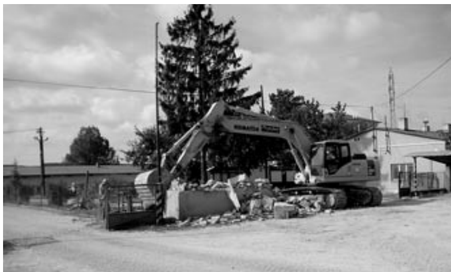
Bagr stavební firmy provádí demolici objektu, který následně nahradí příjezdová komunikace s chodníkem na ulici Jihlavská
