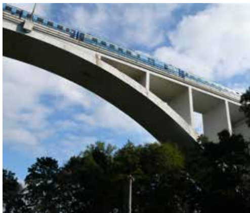
Moderní železniční trať Brno – Havlíčkův Brod s unikátním železobetonovým obloukem u Dolních Louček, s kdysi největším železobetonovým obloukem ve střední Evropě. Foto: Alois Koukola
