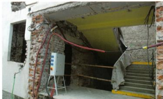
ZATÍM STAVBA PŘIPOMÍNÁ DEMOLICI 7. května
