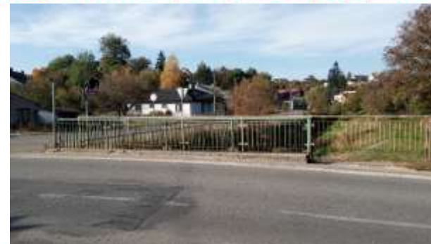
Oprava lávky Za Potokem - pravá (směrem pro příjezd do města)
